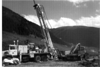
Figura 3: perforació del pou termal d'Incles. Font: Enginesa
