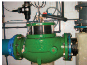
Vàlvula irua de la planta (ETAP)
