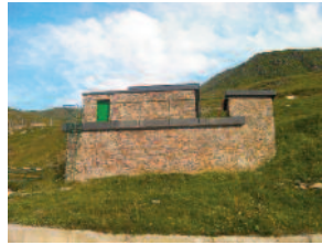
Dipòsit de Gasopas
