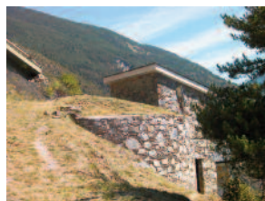
Dipòsit de Vila
